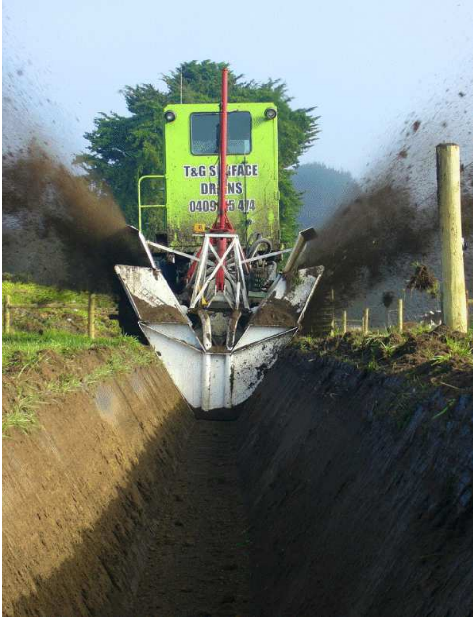
شكل (٣-٤) ماكينة إنشاء المصارف المكشوفة أثناء العمل
