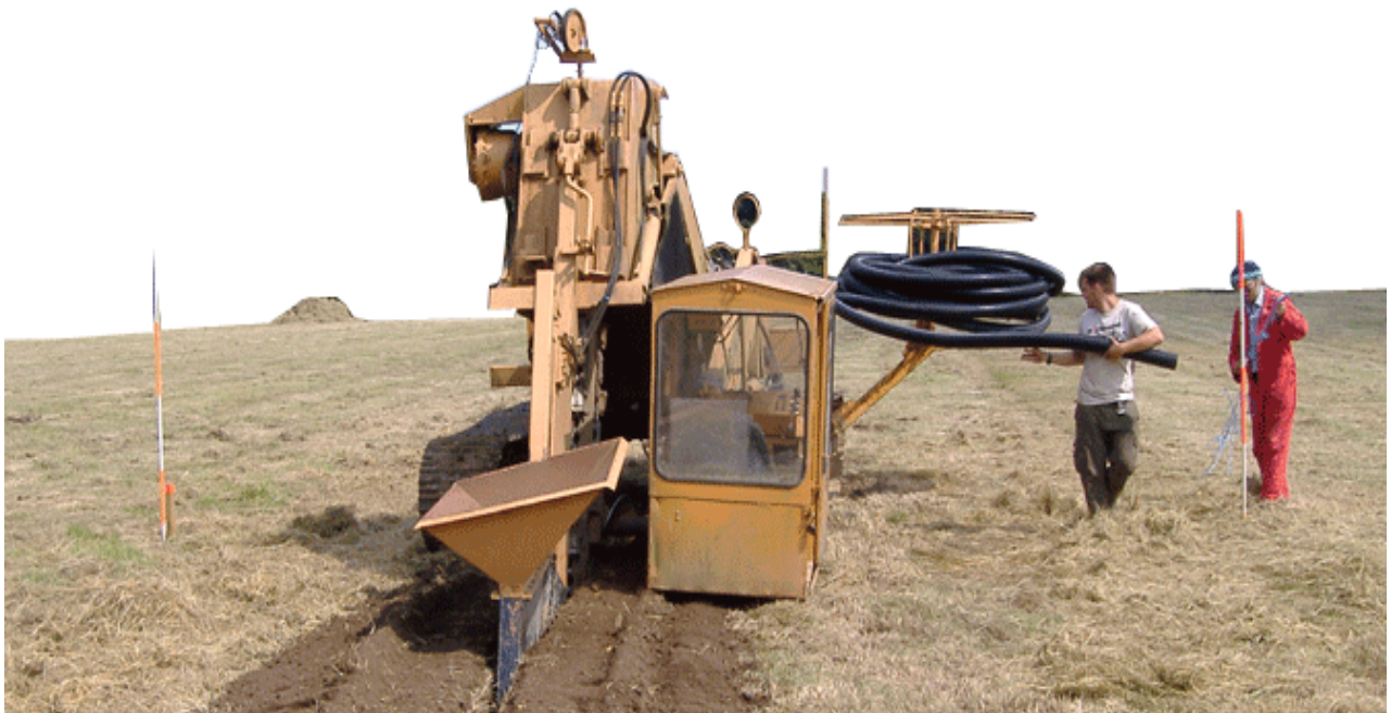
شكل (٤-٦ ب) ماكينة حفر وتركيب المصارف المغطاة
