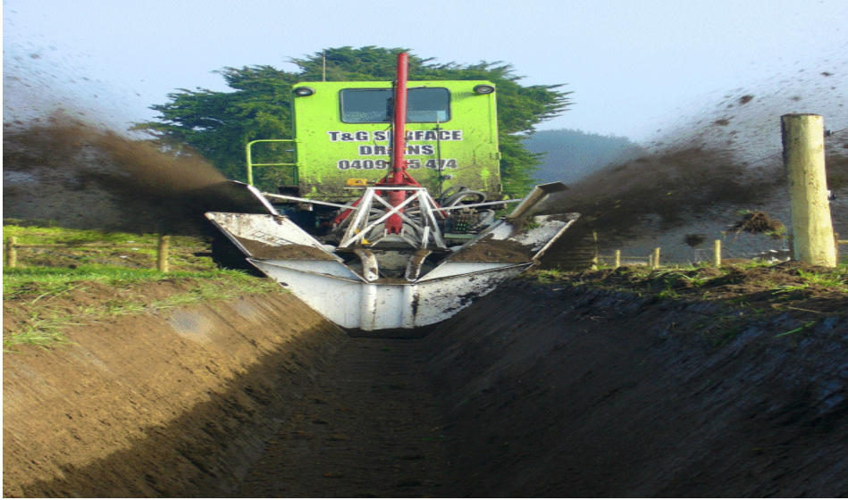
شكل ( 101 ) الصرف السطحي ( المكشوف ) وكيفية تنفيذه
