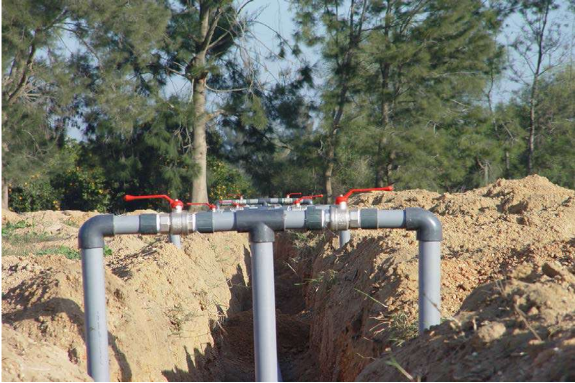
( شكل 50 ) تجهيز القطاع الأرضي لأخذ عينات الدرس العملي الثاني
