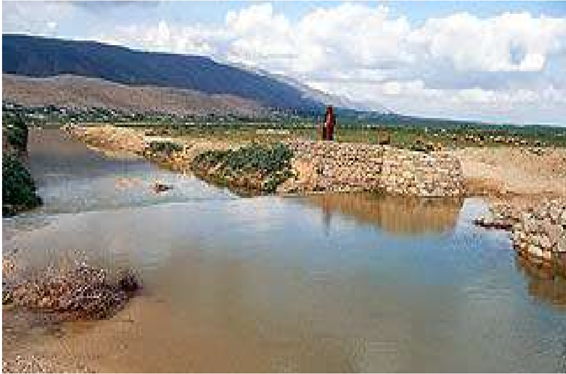
شكل ( 100 ) نظام نشر المياه
