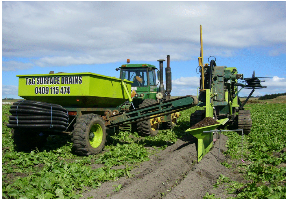
شكل ( 102 ) نظام الصرف التحت سطحي ( المغطي ) وكيفية تنفيذه
